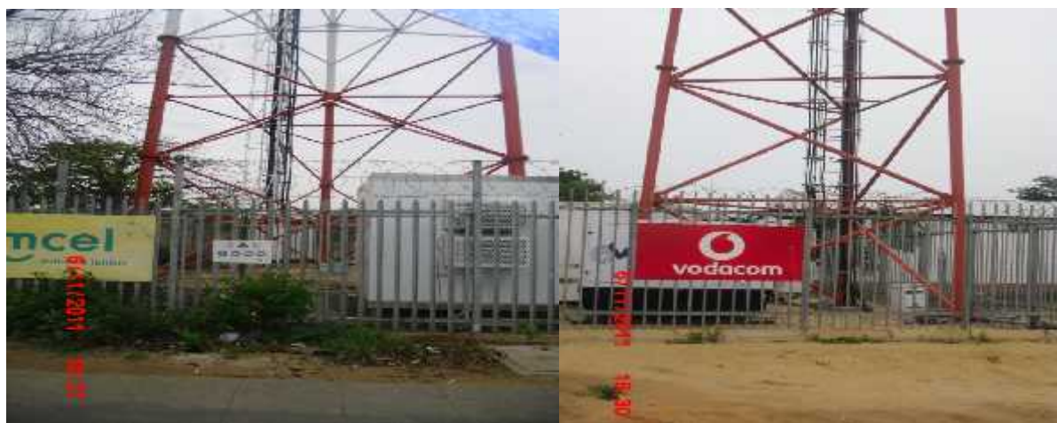
Foto 12: Infra-estruturas de telecomunicações - antena de telefonia móvel
