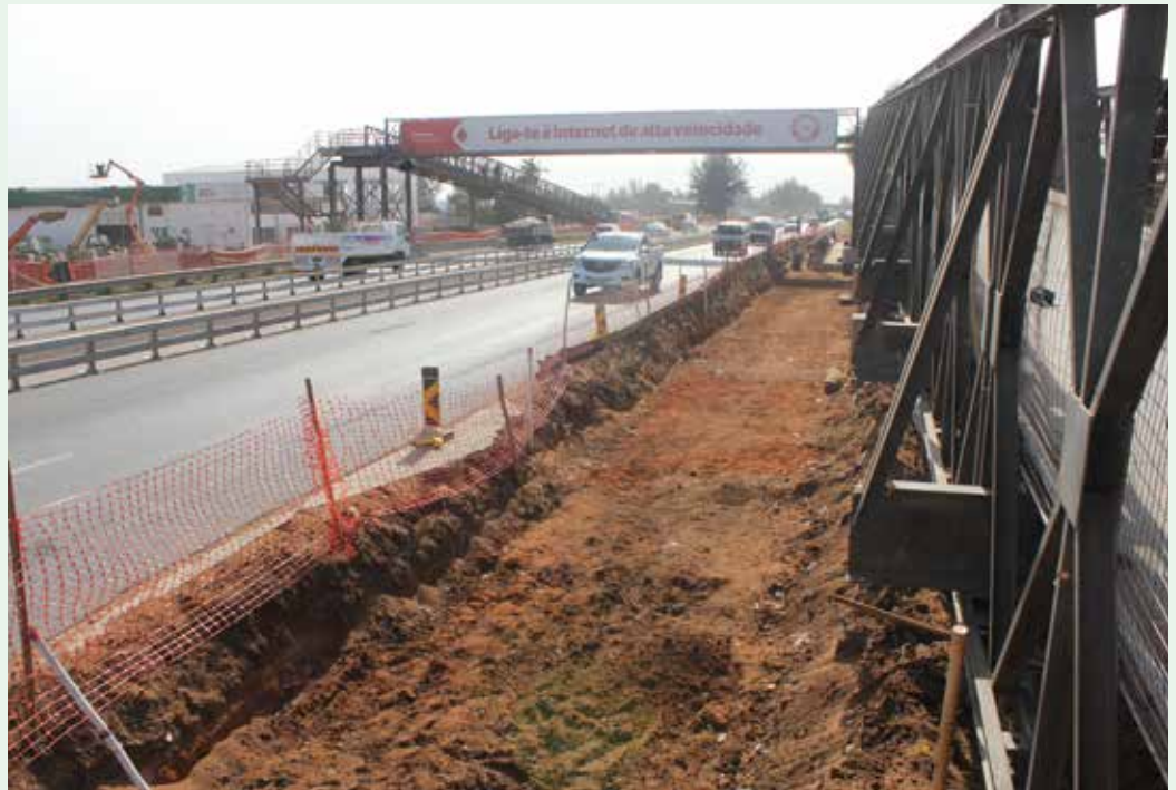
O troço Shoprite da Matola-Praça 16 de Junho está a ser alargado
